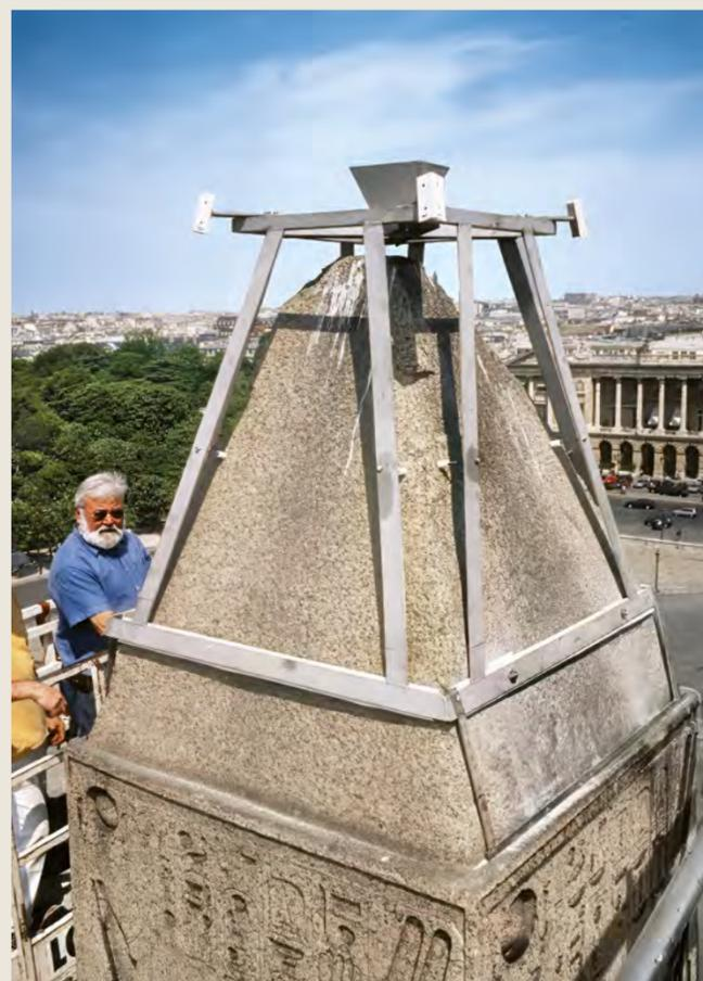
Fig. 3. La fixation du cavalier en inox.
