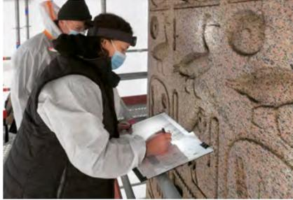
Fig. 1 à 4. Réalisation du relevé des altérations du monument avant intervention.
